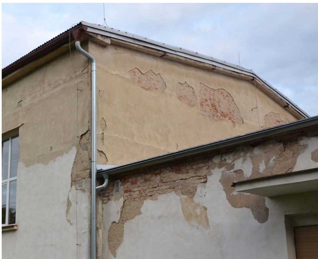
Obr 4: Poruchy omítky se nachází zejména na severozápadní a jihozápadní stěně.
