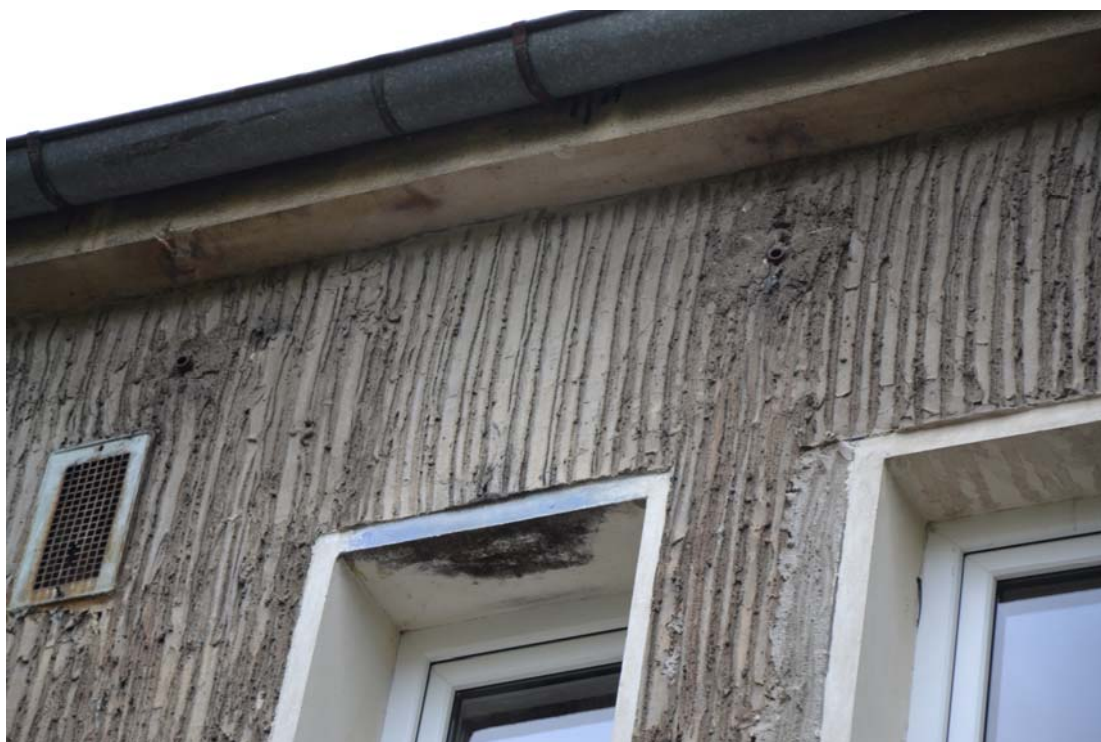
Obr 3: Malé odvětrávací trubičky na severovýchodní stěně.
